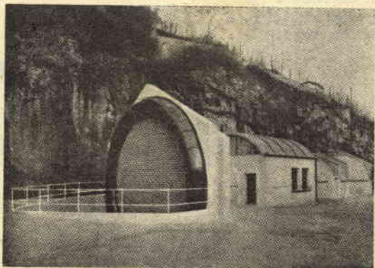
Ecco come appare, in una visione panoramica, il Tunnel del vento realizzato dalla Guzzi. E' questo il primo impianto del genere realizzato in Italia e, per il momento rimane l'unico a cui i nostri tecnici possono ricorrere.
